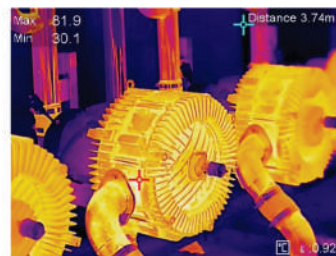
Инспекции механического оборудования
