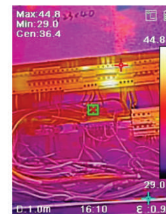
Проверить электрических сети
